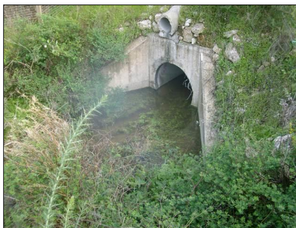
Figura 3.9 – Ponto de recolha km 8+154 (lado esquerdo da via).
